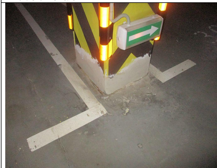
Кор.3-4, эт.-1 Нижний уровень паркинга Подготовка колонн к покраске -подготовка поверхности -шпаклевание колонн
