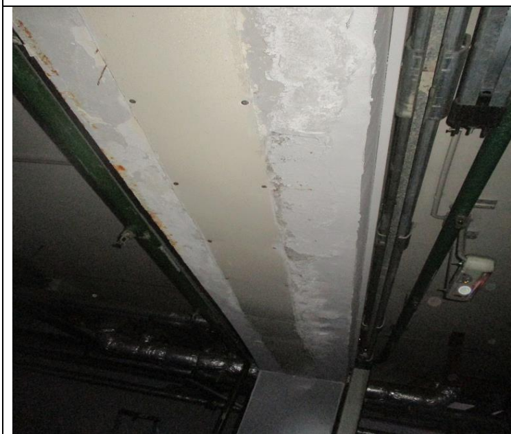
Кор.2, эт.-1 Нижний уровень паркинга Ремонт откосов -облицовка откосов стальным листом
