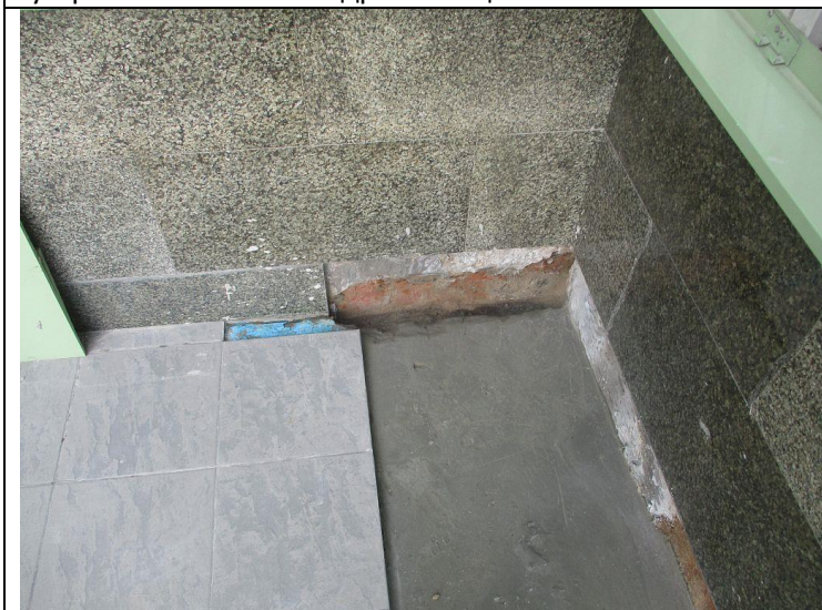
Кор.1, эт.2 Территория Устройство жесткой гидроизоляции -подготовка поверхности -устройство жесткой гидроизоляции
